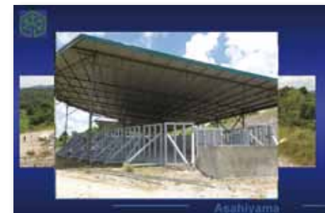
【図3】 2013年はゾウのバドックなど最低限の施設をつくり、2014年に屋根工事、水道工事を終えた。屋根にはスプリンクラーも設置されている。
