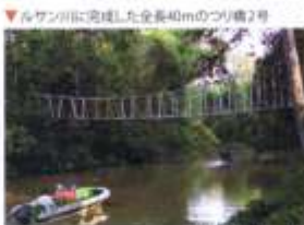
▼ルサン川に完成した全長40mのつり橋2号 写真提供: BCTジャパン
