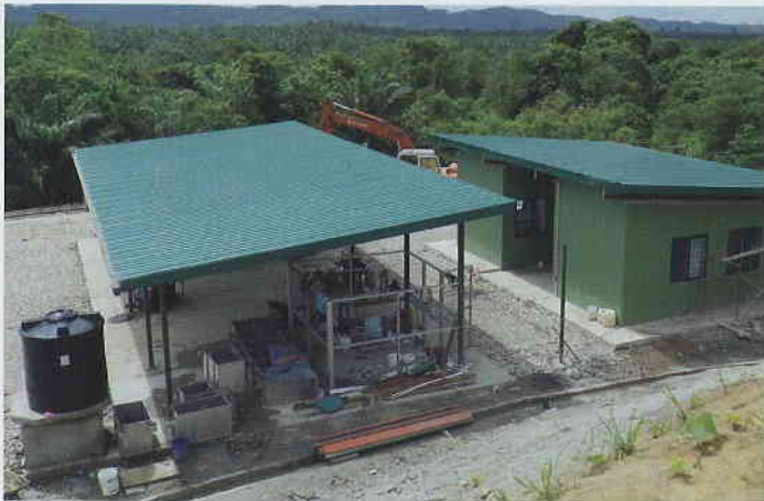
写真左が倉庫、上の全景写真の右側に一部が見える。倉庫の左側の黒い円筒形のは雨水を貯めるタンク。写真右はスタッフコートで、4ベツトルーム、キッチンがある。自家発電機やトイレは建物の外側にある。
