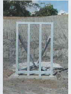
幅1.6m 高さ(地上)2.2m 重量 約180kg 組み立て式。コンクリートに固定されている。水平に4トンの力がかかっても耐えられる。外側にたくさんの突起をつけ、鼻を巻けないようにしている。
