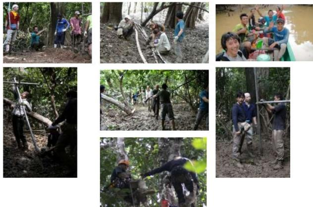
日本人チームは13日午前中で現場から引き揚げ帰国準備に入った。その後、サイモンとアシスタントが16時ぐらいまで現場に残り、両岸での消防ホースの固定と、監視カメラの設置を行った。人工支柱の脚部はボルネオ鉄木の板で地盤への沈み込みを防止している。
