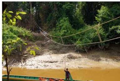
片方のロープがしっかりと固定されたらボートでロープを渡し、今度は対岸に移動します。綱引きの要領で、ロープを引っ張り上げるのですが、全長70mのロープは重量もかなりのものですが、共同作業がスムーズに進んだお陰で、水面から8mほどのところに水平に日本のロープが張られました。
