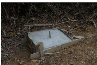
南側の樹木に支柱を取り付けるための部品をつけます。支柱はワイヤーで左右から引張って支えるのですが、ワイヤーを固定するためのコンクリー
