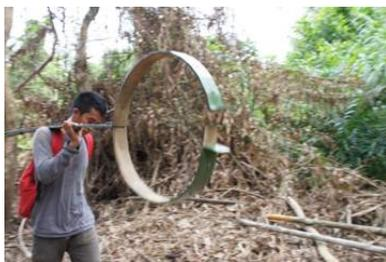
選んだ木のうち1本は、吊り橋を支えるためには少し強度に不安があったため、樹木を支えるための支柱を取り付けることにしました。そのための器具を手作りします（といっても到着時には完成していたのしたが）。幹に取り付ける部分は、将来幹が成長して太くなることを考慮し、調節できるようにになっています。
