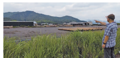
指さしの先は、建設中のパーム油発電所
